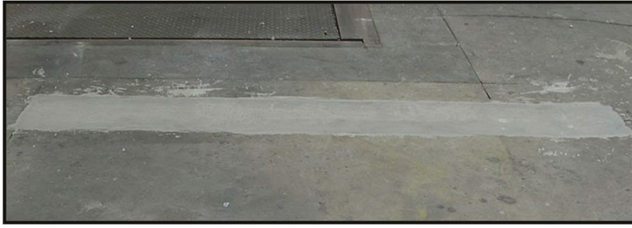
Fig. 2: Corte de instalación de tuberías después de su reparación.
