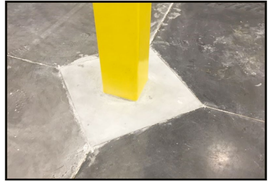
Fig. 3: Detalle de anclaje o aislamiento de columna después de la reparación.
