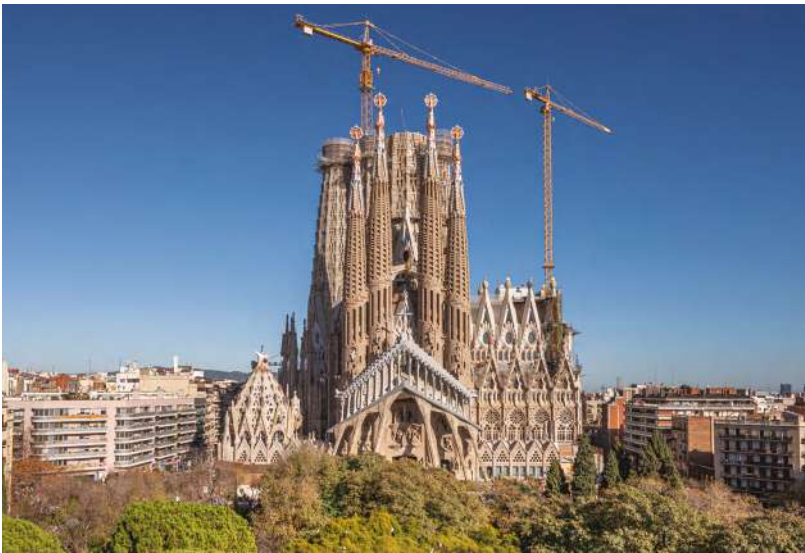
Fig. 2: La fachada de la Pasión presenta dos campanarios de 112 m (367 pies) flanqueados por dos campanarios de 102 m (334 pies). Detrás de estos, seis torres más están en construcción (© Fundació Junta Constructora del Temple de la Sagrada Família)
