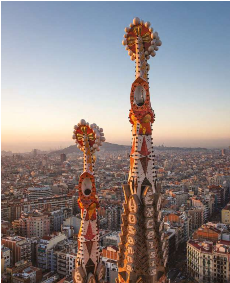
Fig. 3: Detalle de dos pináculos de las agujas de la fachada de la Pasión. Las torres están decoradas con mosaicos (© Fundació Junta Constructora del Temple de la Sagrada Família)
