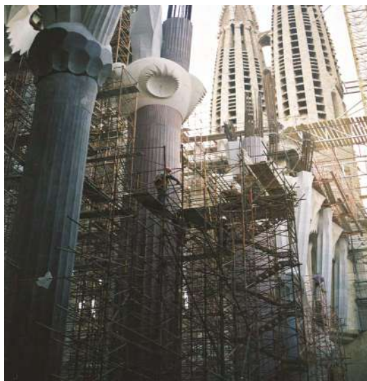
Fig. 6: Se utilizaron “tambores” exteriores de piedra o de concreto prefabricado para formar los troncos y las ramas con núcleos de concreto reforzado (© Fundació Junta Constructora del Temple de la Sagrada Família)
