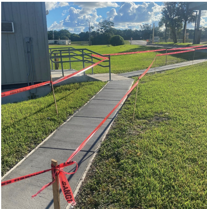
Fig. 3: Banqueta con BA de la incineración de RSU en la Autoridad de Residuos Sólidos del condado de Palm Beach, FL
