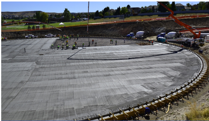
El concreto ligero aumenta el área de colocación mediante la hidratación continua. (foto cortesía Instituto de Agregados Livianos de Esquisto, Arcilla y Pizarra Expandida)
