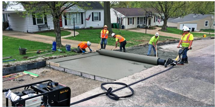
Para colocaciones de concreto monolítico los contratistas se benefician al usar una máquina de manera simultánea para dar forma al bordillo, drenaje y pavimento. Esta capacidad se presenta en forma de un tambor personalizado con una regla hidráulica.
