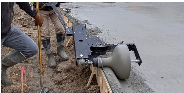
**Máquinas de perfilado guiadas a pie con kits monolíticos y equipo de perfilado operado a batería son dos opciones que los contratistas pueden considerar para procesos mas eficientes que los realizados de forma manual.**
