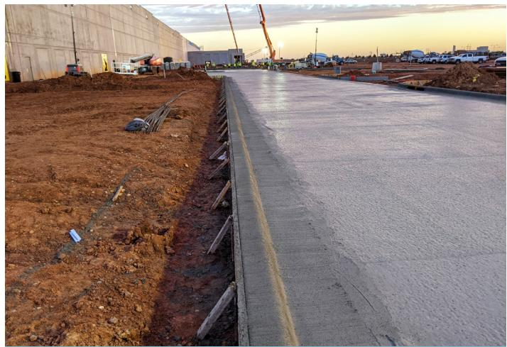
*Los procesos de colocación monolíticas mejoran la eficiencia completando el pavimentado y perfilado de bordillo y drenaje al mismo tiempo* (todas las fotografías son cortesía de Curb Roller Manufacturing)
