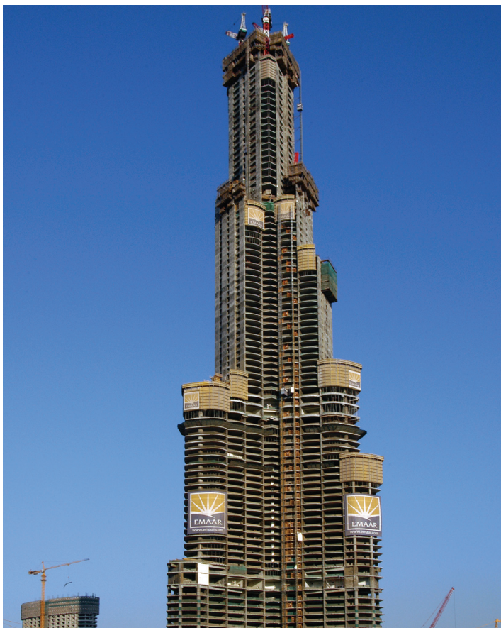
El edificio Burj Khalifa en construcción en Dubái, EAU (foto cortesía de SOM).
