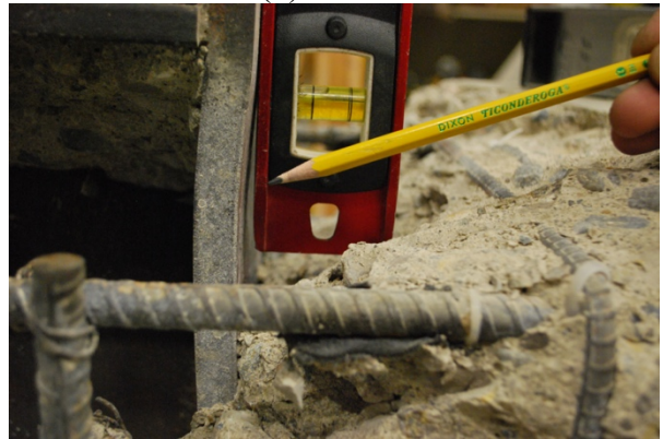
(d) Local flange bending
