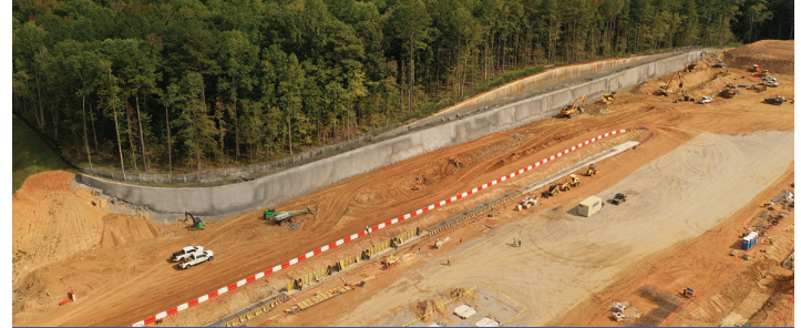
Vista aérea del muro completado.
