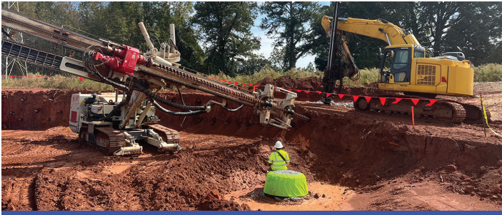
Perforación en agujeros a cielo abierto.
