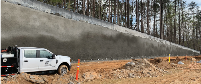
Después de la aplicación de concreto lanzado aplicado por un robot.
