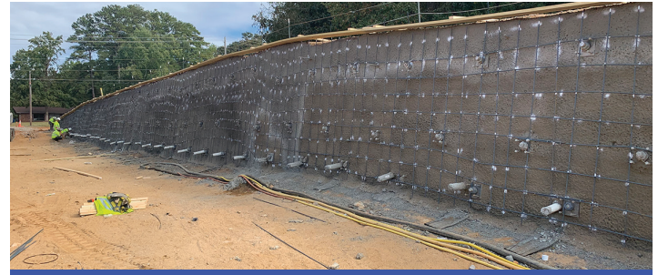
Instalación de clavos en el suelo y malla de alambre instalados durante las primeras etapas de un muro reforzado
