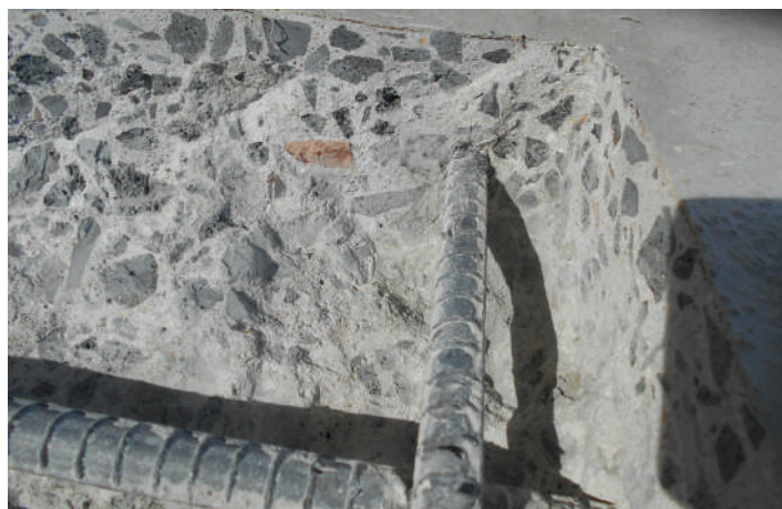
Fig. 3: Acero de refuerzo con buena adhesión aparente sin corrosión significativa.
