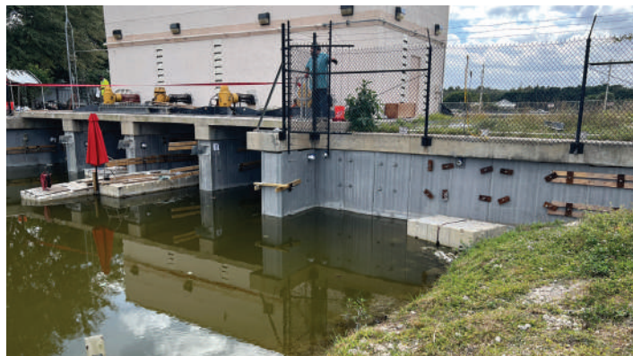
Fig. 5: Reparación de tablestacas de acero corroídas en Weston, FL, EE. UU., en junio de 2024.
