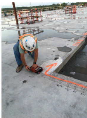
Fig. 4: Se marcó la trayectoria de los cables de postensión.
