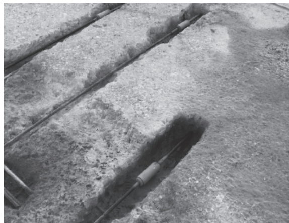
図 - 8 PT ケーブルの接続とシースの修復部
