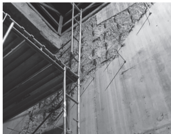
図 - 7 壁上部の修復
