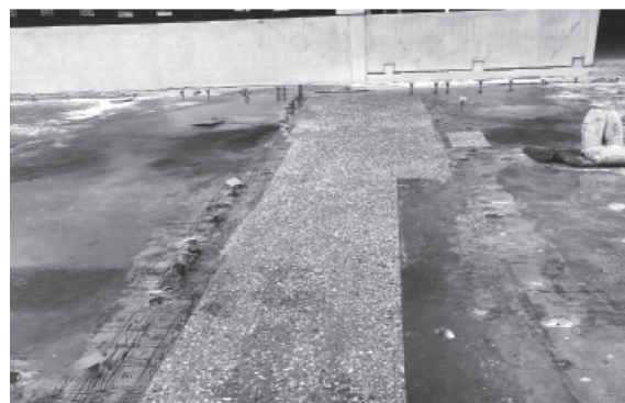
図 - 6 大部分で繰返しはつり出したコンクリート被災部の除去
