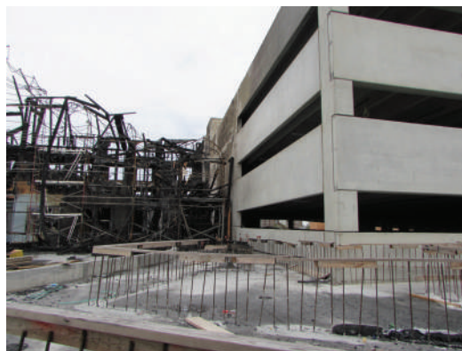
Fig. 2: Otra vista de los daños por incendio a los apartamentos con estructura de madera.
