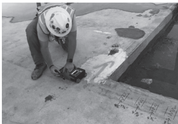
図 - 4 PT ケーブルの探査
