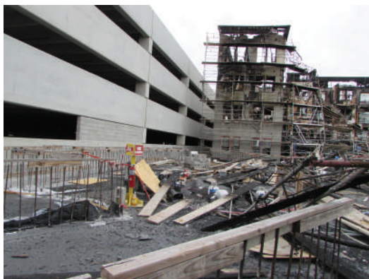
Fig. 1: Daños causados por el incendio a los apartamentos en Riverworks en Eastern Wharf.
