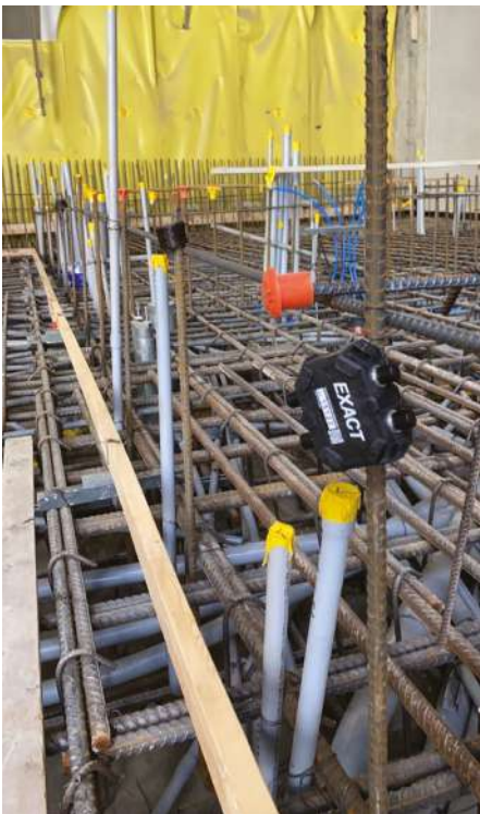
Figura. 3: El equipo de monitoreo de temperatura se instaló poco antes de la colocación del concreto
