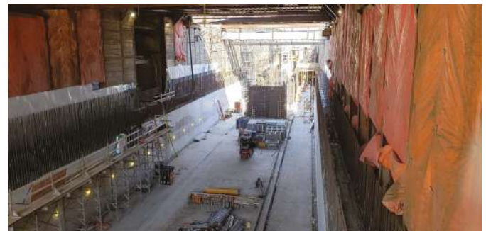
Figura. 2: Múltiples colocaciones de concreto masivo en la estación Eglinton LRT
