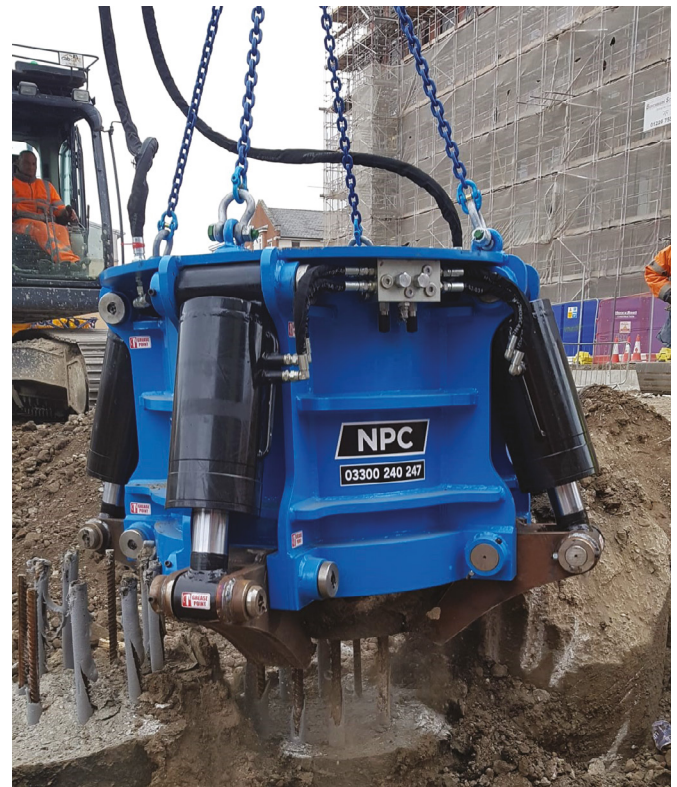
Figura. 1: Una recortadora hidráulica de pilotes haciendo un corte alrededor de las barras de refuerzo
