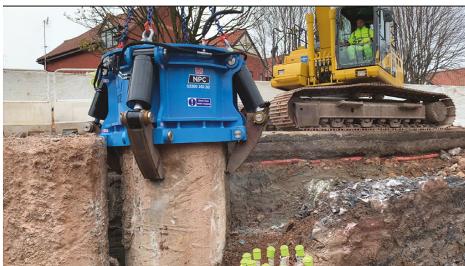
Figura. 2: La recortadora hidráulica posicionada sobre la pila por la retroexcavadora
