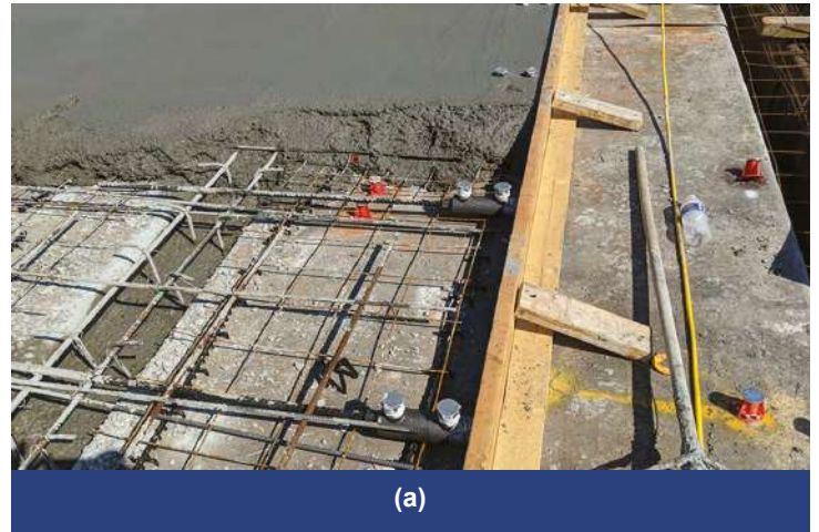
Fig.3 El Sistema de Empalme Mecánico de Barras de Refuerzo PS=Ø puede asegurar continuidad dúctil y una tira de vertido sin espacios.
