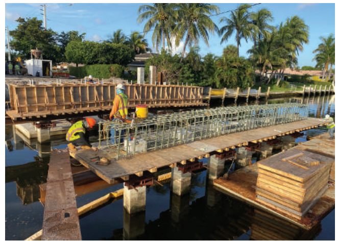
Fig. 4: Puente costero en construcción. Las pilas y el cabezal se reforzaron con barras de refuerzo de FRP suministradas en forma recta y precurvada
