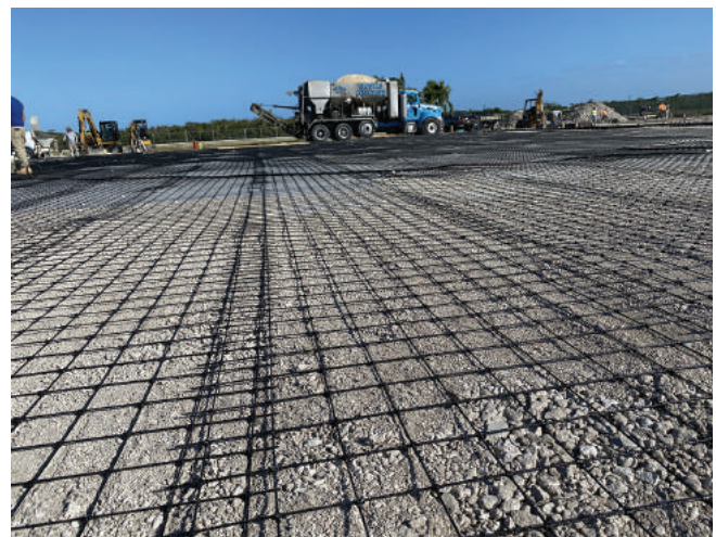
Fig. 5: Las mallas de FRP pueden utilizarse como refuerzo secundario en las losas sobre suelo
