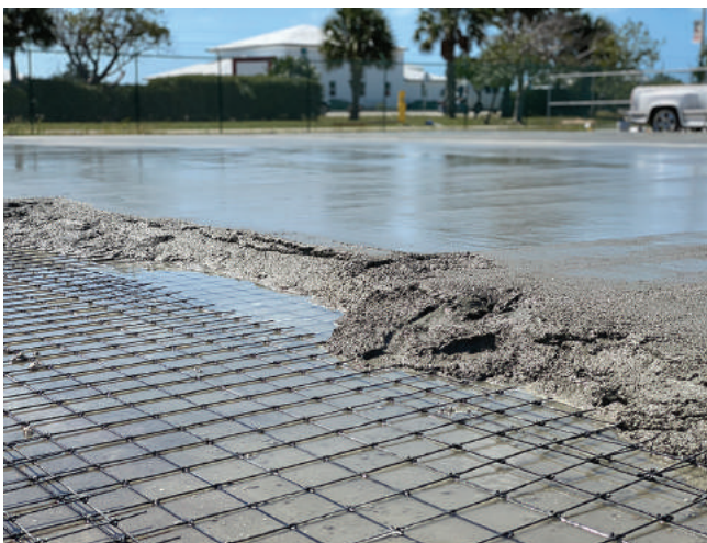
Fig. 5: Las mallas de FRP pueden utilizarse como refuerzo secundario en las losas sobre suelo
