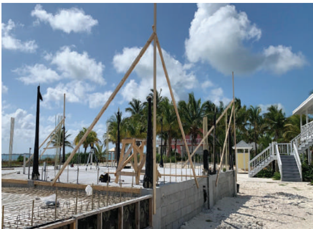
Fig. 3: Residencia costera en construcción. Las losas de concreto, las columnas de concreto y las paredes de mampostería incluían refuerzo de FRP
