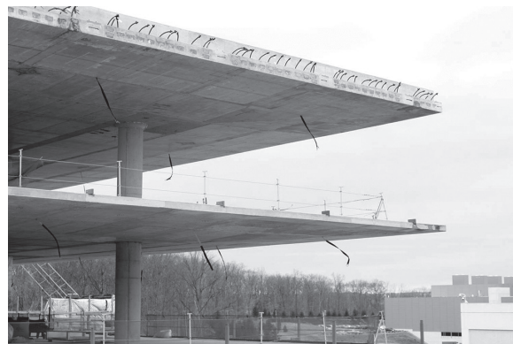
図-5 12mの跳ね出しスラブの角部
