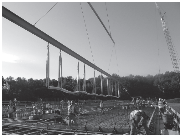
図 - 10 クレーンによる PC 鋼材ユニットの配置
