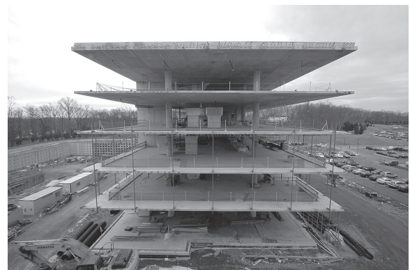
図 - 1 施工中の建物 (ノバルティス社のがん研究センター)
