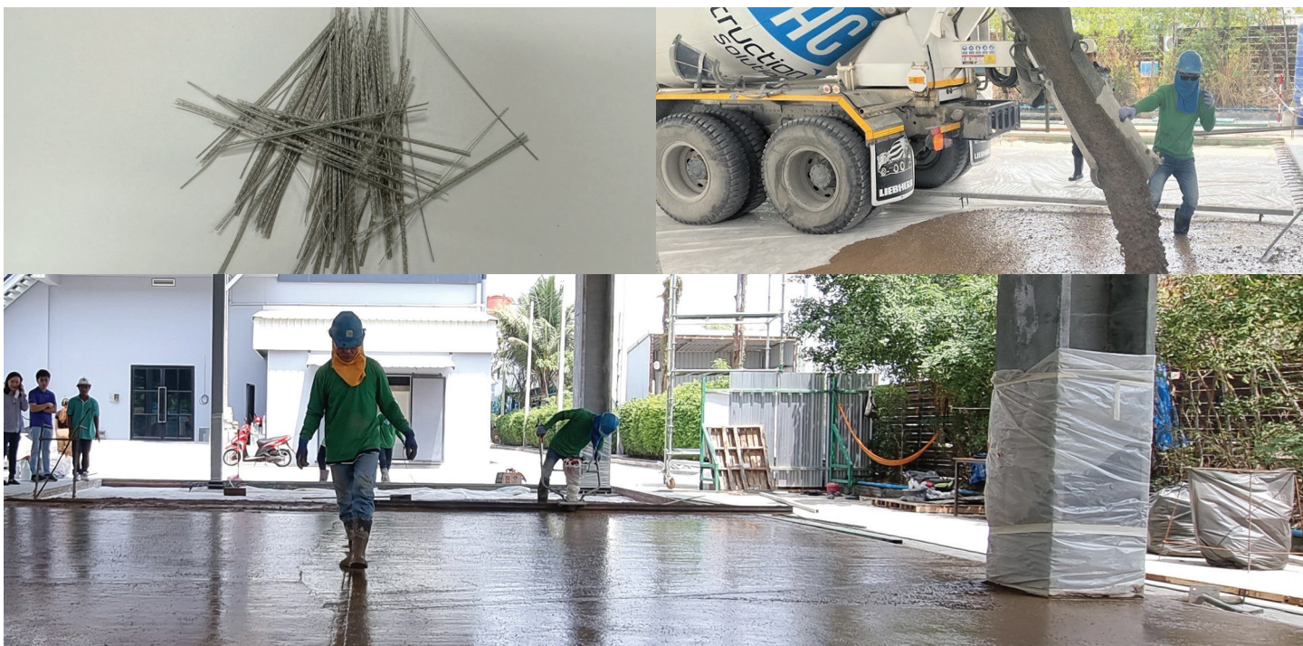
Fig. 9: Fibras utilizadas en el concreto LC3 y en el vaciado del concreto LC3 reforzado con fibras.
