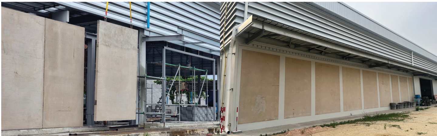
Fig. 8: Instalación de una fachada decorativa de concreto LC3
