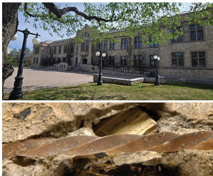
Fig. 3: Edificio Peter McKinnon en el campus de la Universidad de Saskatchewan: (a) vista general; y (b) puerto de inspección que muestra una barra cuadrada retorcida reforzando la losa del piso principal (fotos cortesía de L.R. Feldman)
