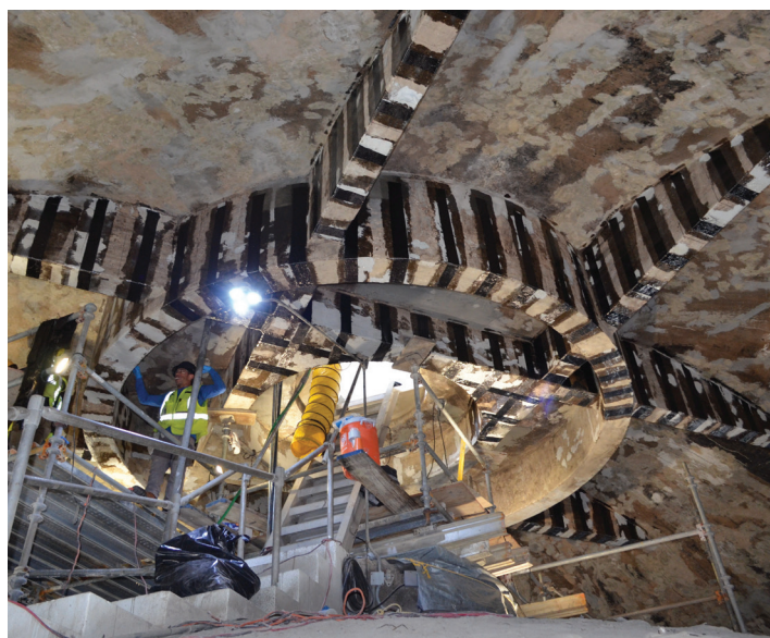
Reforzamiento utilizando láminas de fibra de carbono.
