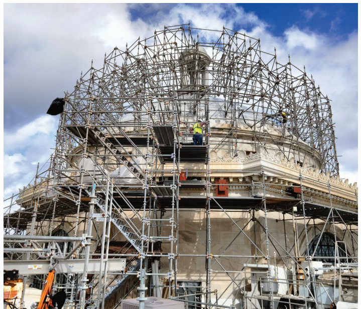
Domo del Capitolio de Puerto Rico durante su restauración.
