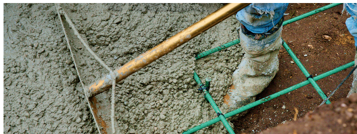
Colocación de concreto con barras de refuerzo de GFRP (foto de cortesía de Mateenbar Composite Reinforcements)
