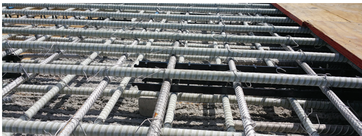
Rejilla de GFRP atada (foto de cortesía de Mateenbar Composite Reinforcements)
