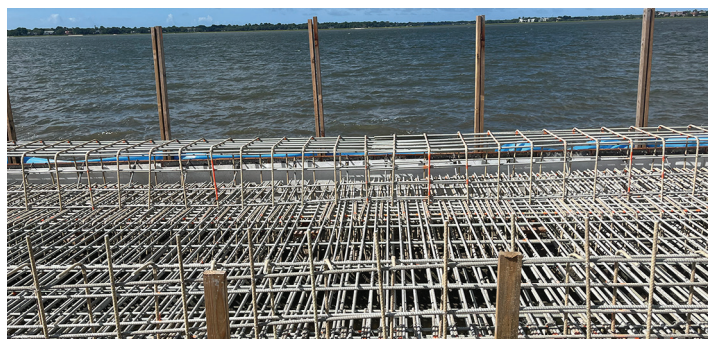
Proyecto de muelle en malecón de Charleston, Carolina del Sur, EE. UU. (foto cortesía de Mateenbar Composite Reinforcements)
