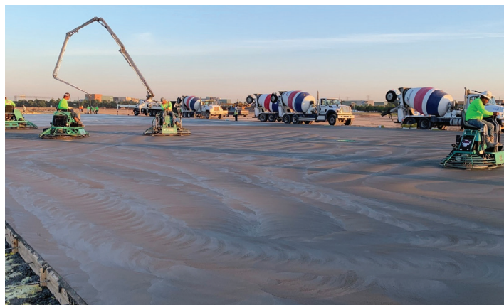
Colocación y acabado de una losa de concreto de PLC (cemento Tipo IL)
