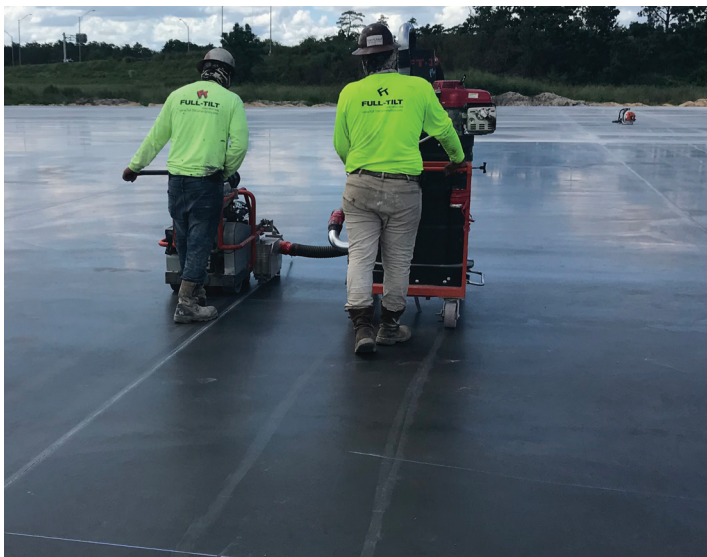
Corte con sierra de las juntas en el momento adecuado para una losa de concreto de PLC (cemento Tipo IL)
