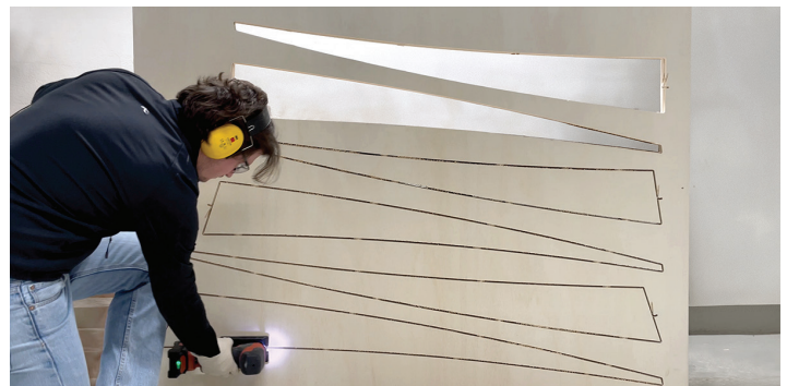
Una lámina de madera contrachapada se corta en tiras individuales con curvatura.
