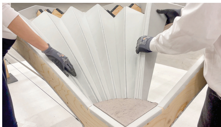
Las tiras de madera contrachapada pueden desplegarse en el sitio como un abanico, adoptando por sí solas la forma curvada deseada.
