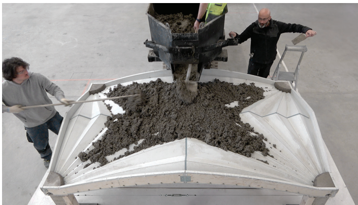
Las cuatro partes individuales se ensamblan para formar el encofrado, el cual tiene la capacidad de soportar hasta una tonelada (1,000 kg) de concreto.
