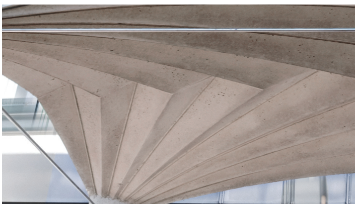
Estructura después de retirar el sistema Unfold Form.
