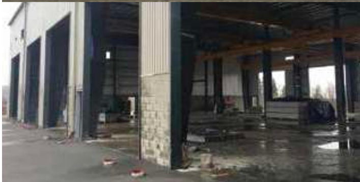
Fig. 2: Almacén de New Brandt Tractor Ltd. en Fort St. John, BC, Canadá, con Hard-Cem utilizado en el suelo de concreto para aumentar la resistencia al desgaste.
