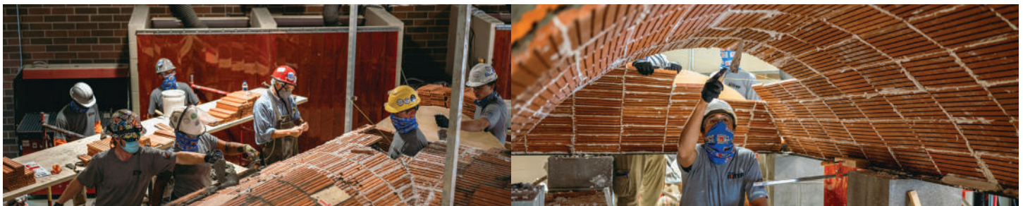
Entrenamiento en restauración arcos estilo Guastavino con losetas en el Centro de Formación Metro Detroit del BAC. (fotos cortesía de IMI y Noah Morrison)
