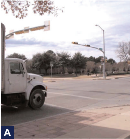
Fig. 5: Vistas del pavimento en Abilene, TX, EE. UU., que fue construido con una mezcla de acero y fibras sintéticas: (a) poco después de la construcción en 2008; y (b) después de 15 años de servicio.
