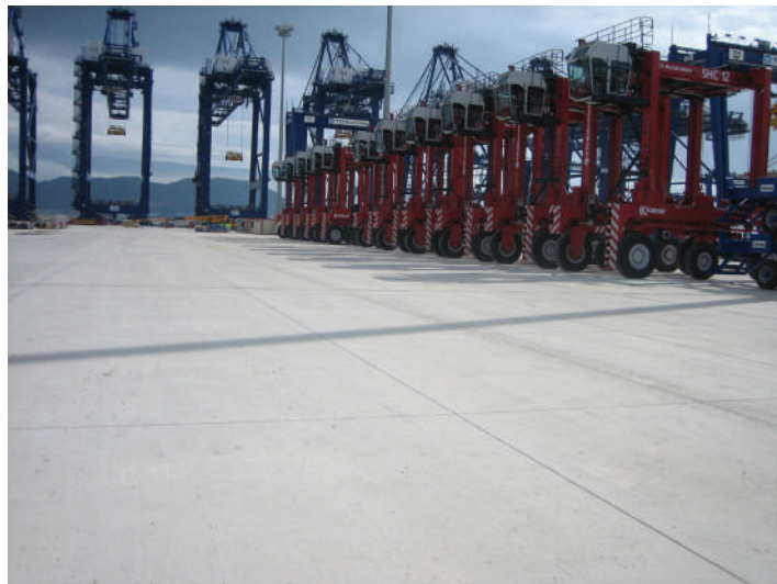
Fig. 1: Pavimento con fibras de acero Tipo I en la Terminal de Contenedores de Maersk, Algeciras, España, construido a finales de los años 1990.
