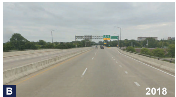
Fig. 3: Vistas del tablero del puente Mason Street en Green Bay, WI, EE. UU., que fue construido con macrofibras sintéticas: (a) durante la construcción en 2005; y (b) después de más de 13 años de servicio.
