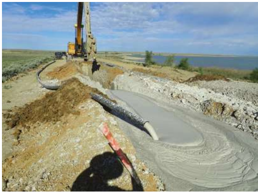
Ampliación del embalse de Big Sandy Dam.
