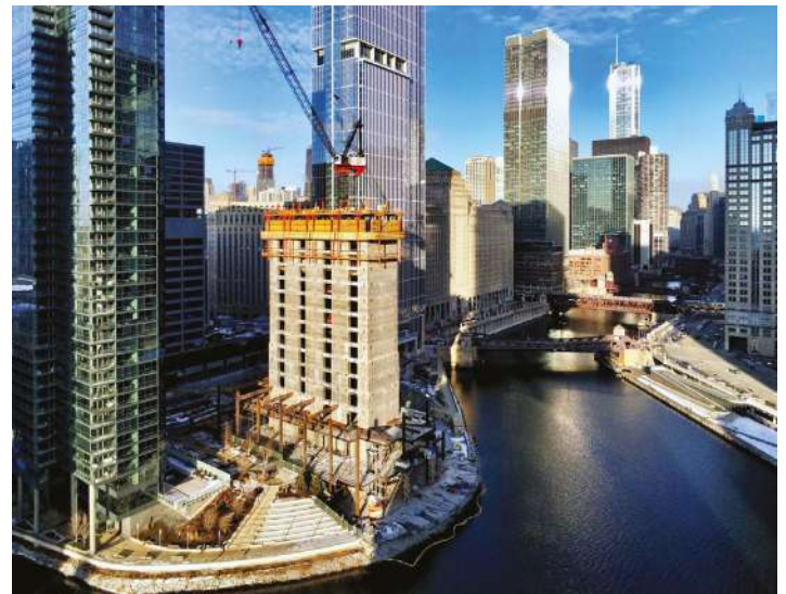
Torre de la Fuerza de Ventas de Chicago.
