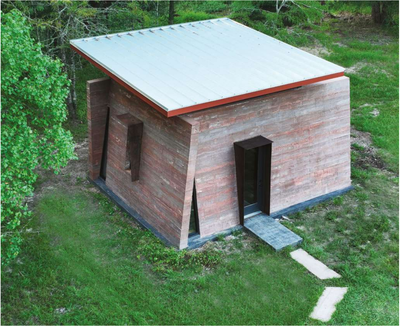
Fig. 4: La cabaña terminada con muros inclinados 8 grados unos contra otros en las esquinas como un castillo de naipes.
