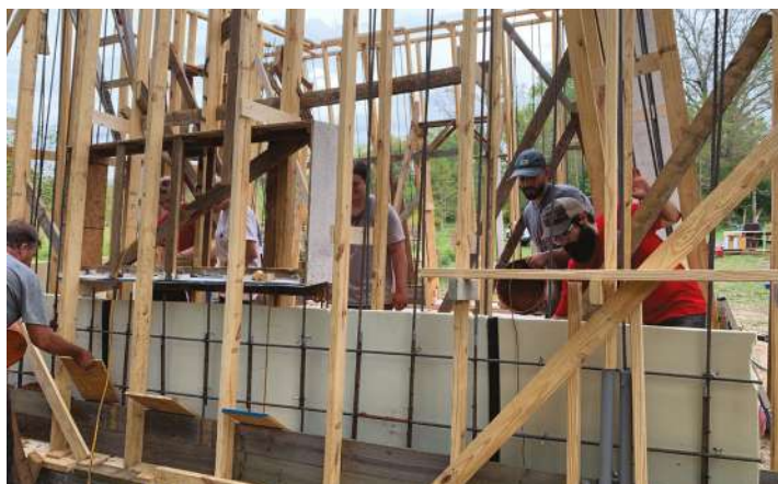
Fig. 2: El aislamiento se instaló en medio de la cimbra del muro antes de colocar el concreto.
