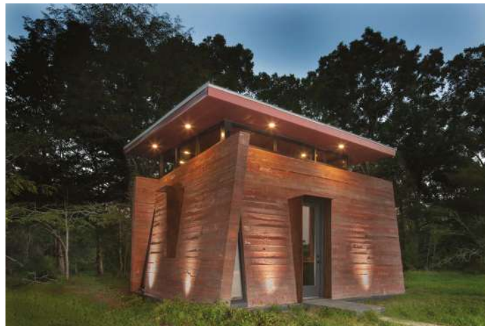
Fig. 1: Un retiro de artistas construido por estudiantes de tercer año y graduados en arquitectura por la Universidad de Louisiana en Lafayette.
