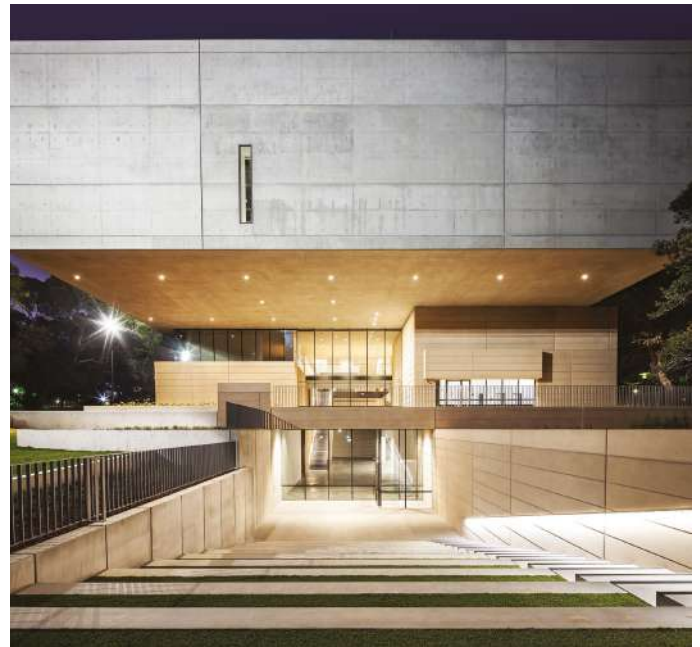
Kiong Lee y Graeme Dix, arquitectos del equipo del proyecto, describen el museo como una expresión directa del concreto como arquitectura, estructura y acabado.
