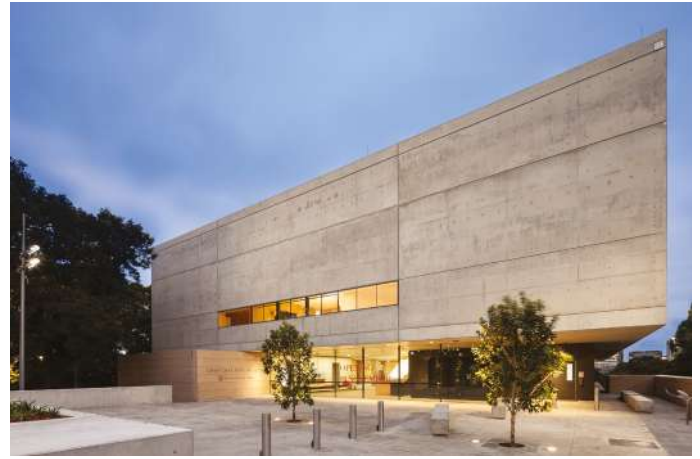
El Museo Chau Chak Wing se diseñó como una caja de concreto en voladizo situada sobre vidrio y un podio prefabricado
