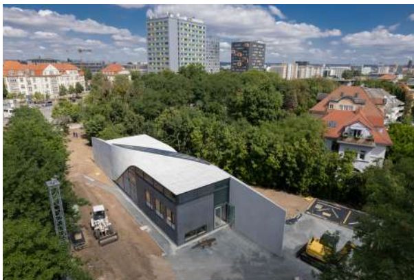
Figura. 1: The Cube durante la construcción con un diseño simple de caja y un techo inclinándose dentro de un muro (foto cortesía de Stefan Groeschel, IMB, TU dresden)
