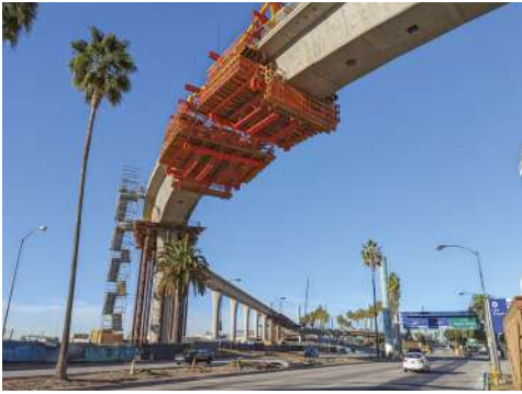
El sistema PERI VARIOKIT en uso durante la construcción del Transportador de Personas Automatizado en LAX en Los Ángeles, CA, EE. UU. (fotos cortesía de Arellano Associates)
