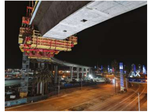
El sistema PERI VARIOKIT en uso durante la construcción del Transportador de Personas Automatizado en LAX en Los Ángeles, CA, EE. UU. (fotos cortesía de Arellano Associates)
