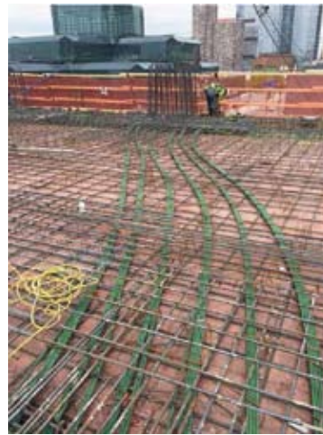
図 - 4 PC 鋼材と普通鉄筋の床配筋
