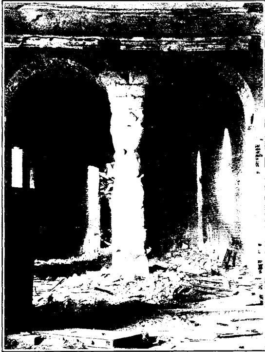
FIG. 10.—INTERIOR STONE COLUMN, CITY HALL, SAN FRANCISCO.
